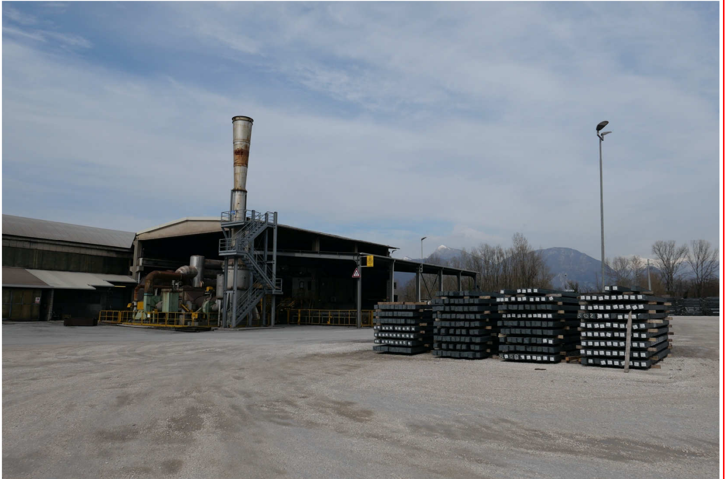
Figura 3.3.6 - Vista su magazzini billette e forno di riscaldamento
